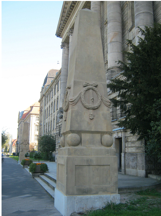
Halbtransparente, wasserabweisende und reversible Beschichtung auf Silikonharzbasis auf Sandstein.
