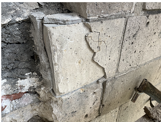
Schalenbildung an einem sehr feinkörnigen Tuffstein etwa 40 Jahre nach einer Hydrophobierung. Viele Tuffsteine weisen ein hohes hygrisches Quellmaß auf.
