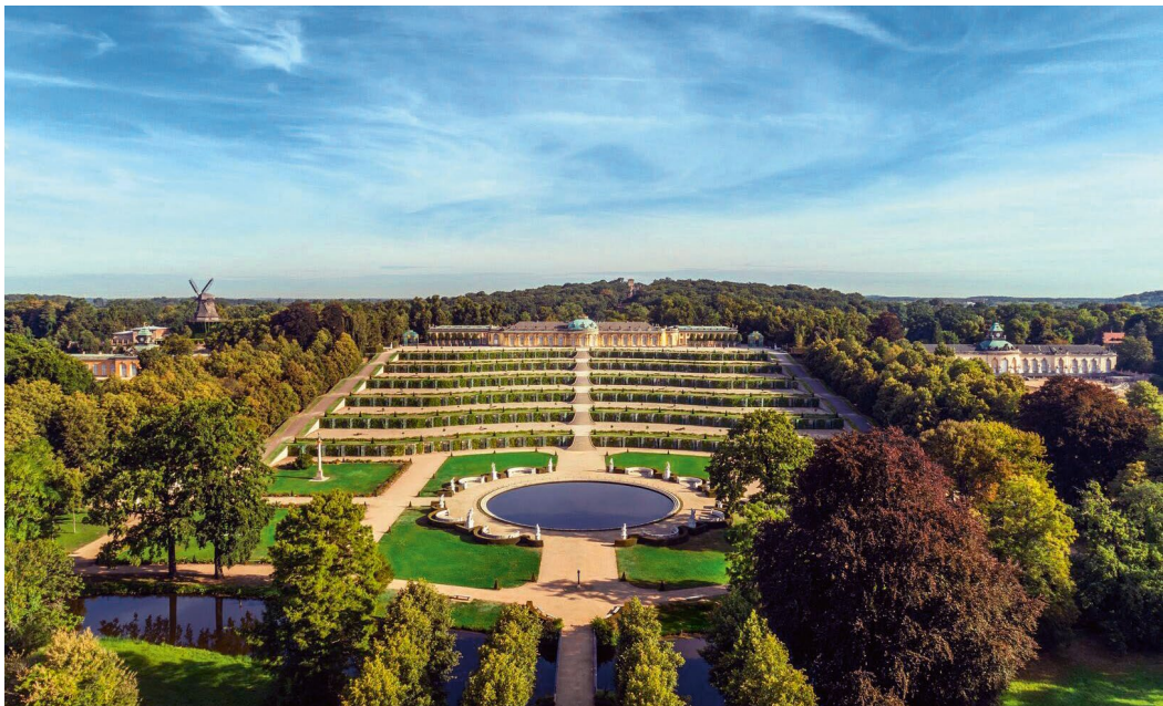
1 | Blick auf Schloss und Park Sanssouci – der formale Bereich mit den vorgelagerten Terrassen und der großen Fontäne im Zentrum des Parterres ist charakteristisch für die Barockgärten des 18. Jahrhunderts.
