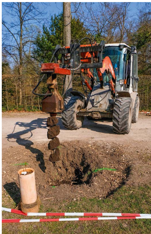
8 | Tiefenbohrung mit Erdbohrer am Boden des Pflanzlochs.
