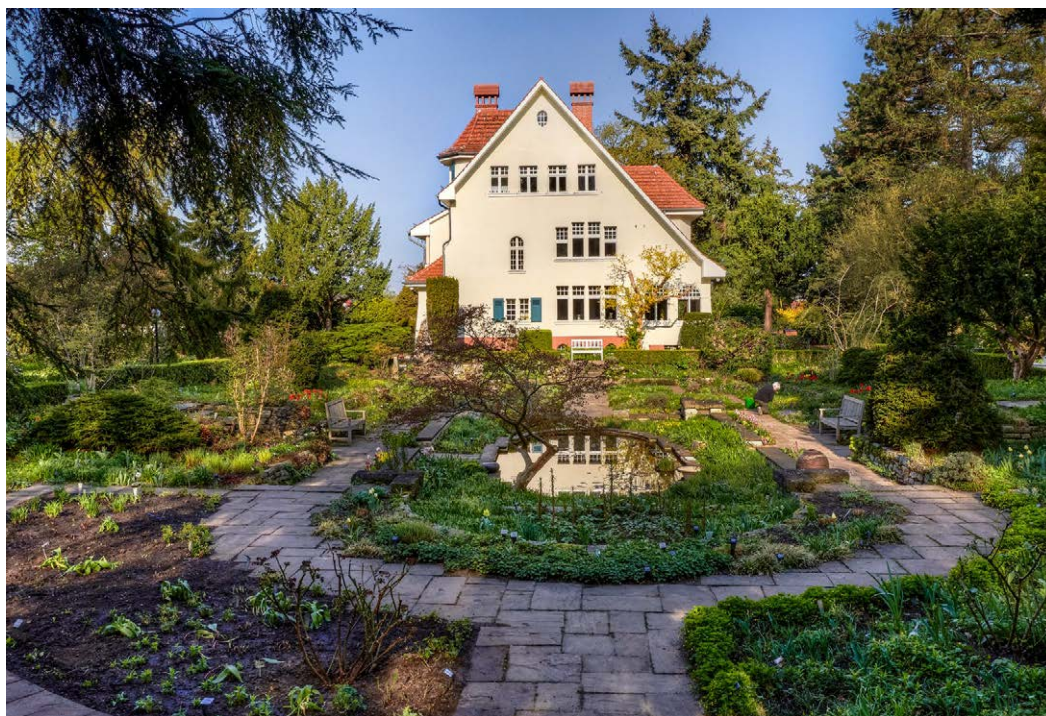
1 | Brandenburg, Potsdam-Bornim, Wohnhaus und Garten Karl Foerster; ein Haus der Deutschen Stiftung Denkmalschutz. Der Erhalt des Pflanzenbildes ist die große Herausforderung im Klimawandel.
