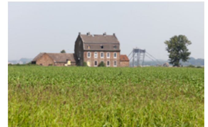
Verlassenes Haus bei Düren-Merken an der Abbruchkante vom Tagebau Inden, Schaufelradbagger im Hintergrund
