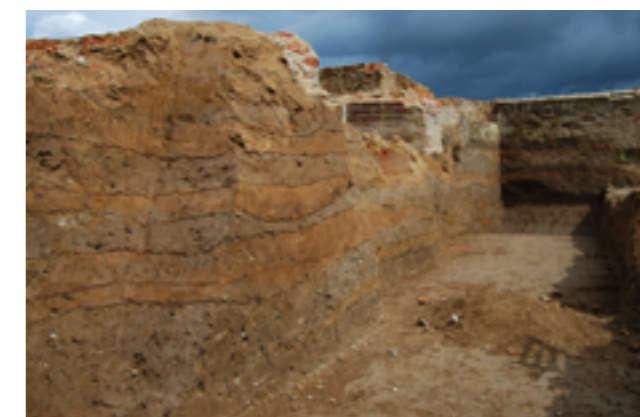
Aufgeschüttete Erdschichten unter dem Fundament des mittelalterlichen Wohnturms des Ritterguts Haus Palant, Borschemich
