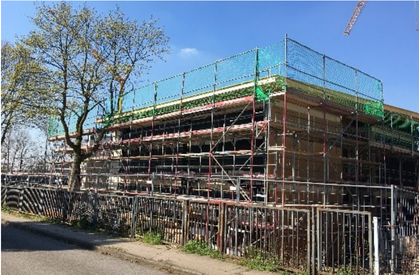
Bild 30 – Neubau Übermittagsbetreuung, LVR-David-Ludwig-Bloch-Schule
