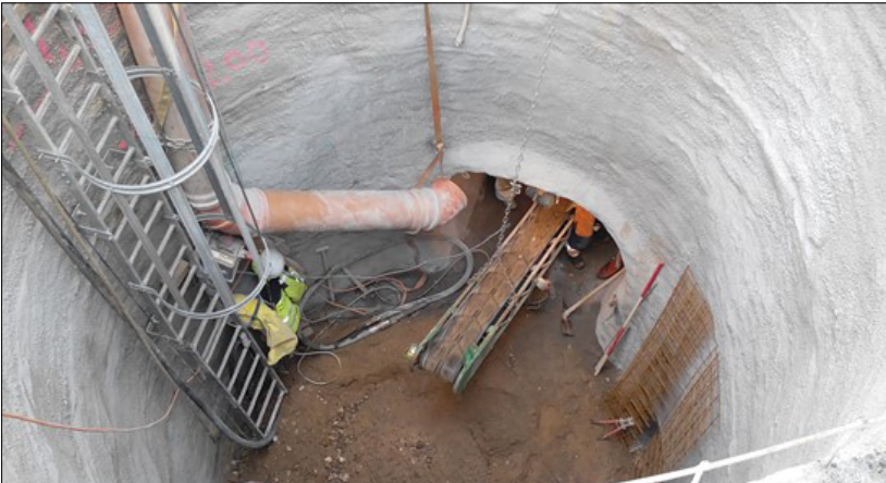
Bild 11 – Bohrung im Zuge der Wasserversorgung
