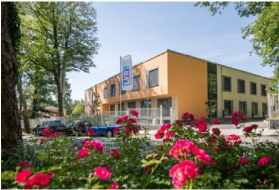
Bild 22.1 und 22.2 – LVR-Klinik Langenfeld, Dependance Solingen, Neubau Stationsgebäude
