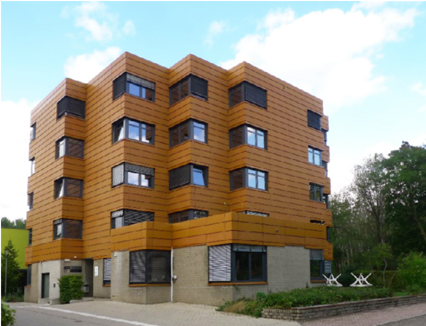
Bild 17 – LVR-Berufskolleg Düsseldorf; Sanierung Fenster, Fassade und Sonnenschutz Quelle: © Architekturbüro Michael Schumann
