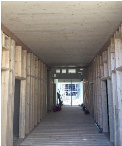
Bild 9 – Gebäude in Holzrahmenbauweise
