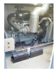
Durch den Betrieb der Anlage werden u.a. CO,  $CO_2$ ,  $SO_2$ ,  $NO_x$  und Kohlenwasserstoffe freigesetzt. Es ist anzumerken, dass durch die Kraft-Wärme-Kopplung nur vergleichbar geringe Emissionen erzeugt werden.
