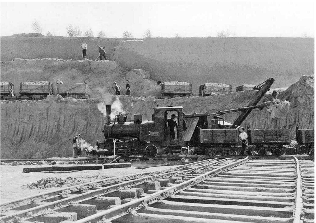
**Abb. 53** Stufenweises Abgraben der oberen Formsandschicht mit Hand und Beladen der Loren. Die Lokomotive steht auf der unteren Abbausohle; aus: Koch (2004a: 66)
