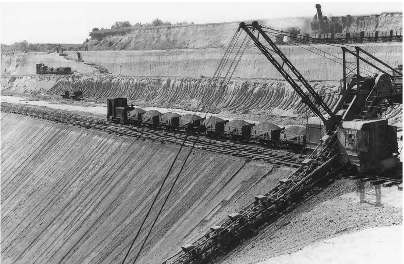
**Abb. 52** Verschiedene Methoden der Formsandgewinnung in der Formsandgrube Eduard Bone II, Grefrath; oberer Bereich: Abbau des Abraums mit Löffelbagger; Bereich links: Abbau der Formsandschicht per Hand; unterer Bereich: Abbau des unverwitterten Formsandes mittels eines Eimerlöffelbaggers; aus: Koch (2004a: 71)
