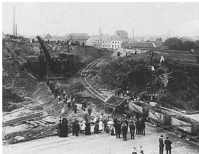
**Abb. 104** Abgrabung „Baggerfeld“ an der linken Seite des Lichtenberges zur Aufschüttung des neuen Bahndammes ab der Krefelder Straße in Richtung Rahser um die Jahre 1915/16, Fertigstellung 1917; KAV 5/2689 und NEEF-WINZ (1954b: Abb. 42).
