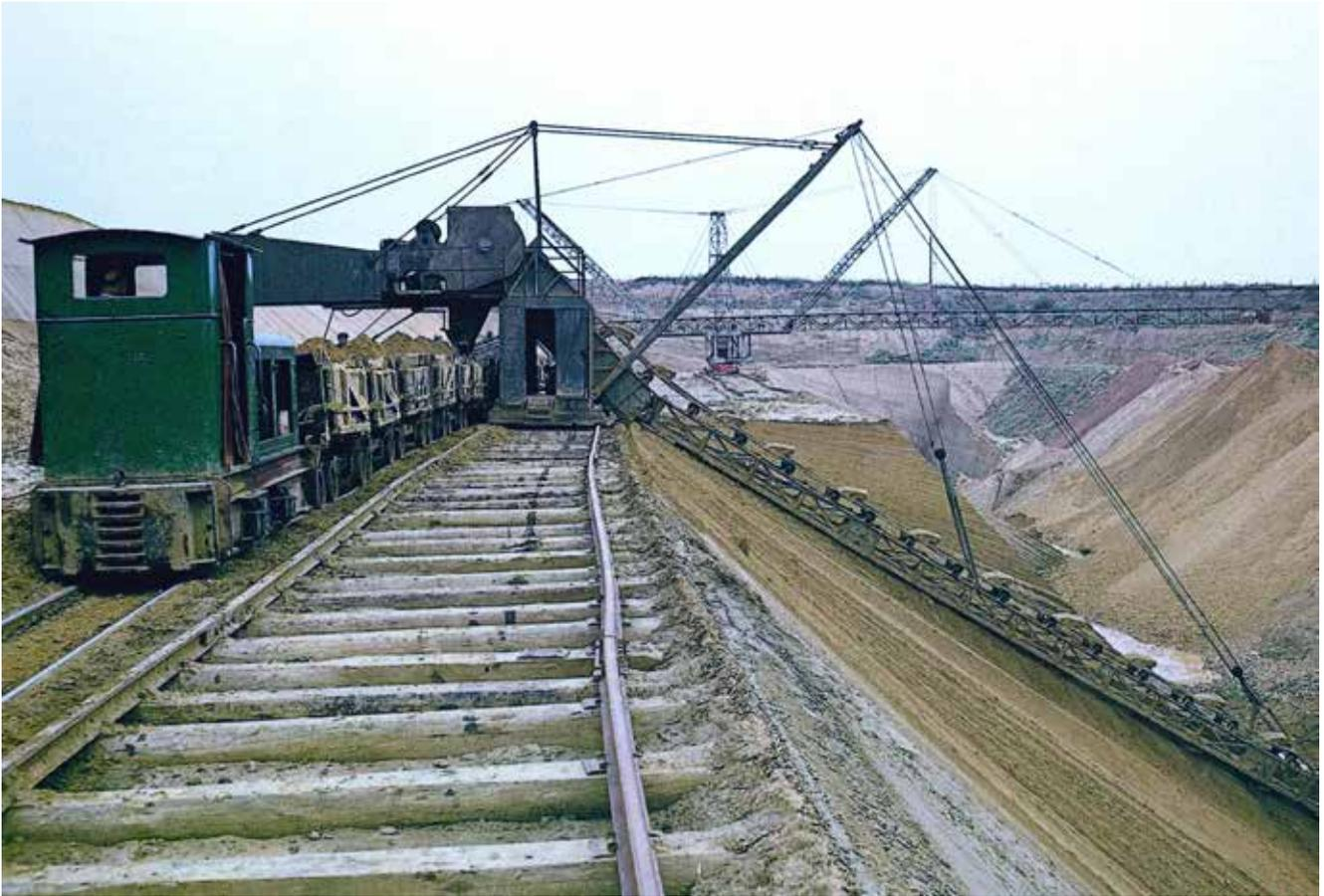
**Abb. 54** Im Vordergrund Umfüllen des Formsandes vom Eimerkettenbagger auf die bereitstehenden Loren. Im Hintergrund Transport des Abraummaterials mittels eines großen Absetzers in den ausgekofferten Grubenteil; aus: Koch (2004a: 81)
