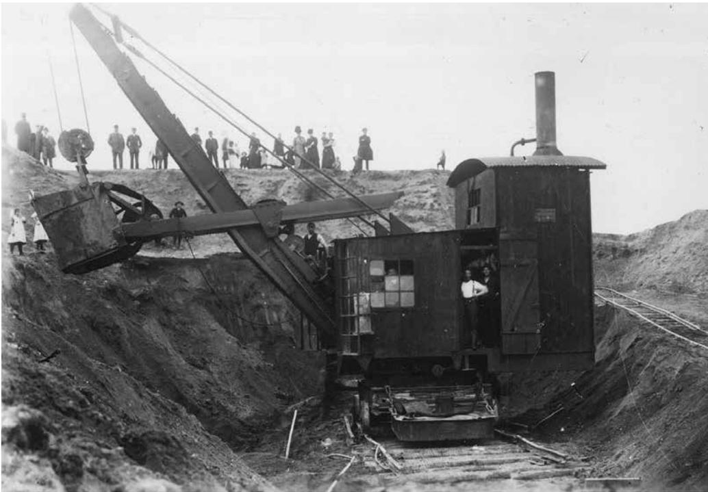
**Abb. 105** Dampfbagger der Tiefbaufirma GRÜN & BILFINGER Act.-Ges; KAV 2119
