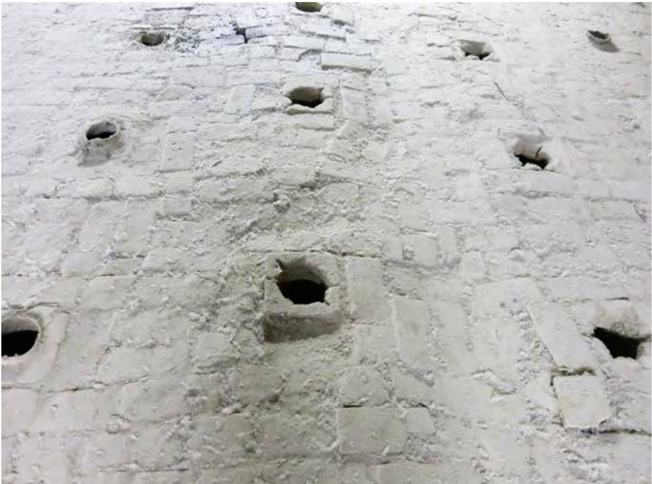
**Abb. 172** Schürlöcher an der Oberseite des Ofenkanals zum Befüllen der Brennkammern mit gekörnter Kohle; Aufnahme von Klaus SKUPIN am 11.09.2014
