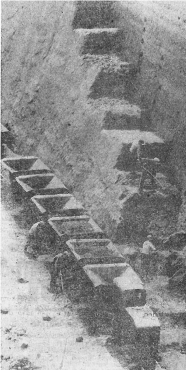
**Abb. 42** Abbau von Formsand in Handarbeit in der Formsandgrube Heinrich NÖTHOFER; Westdeutsche Zeitung, Nr. 131 vom 09.06.1961
