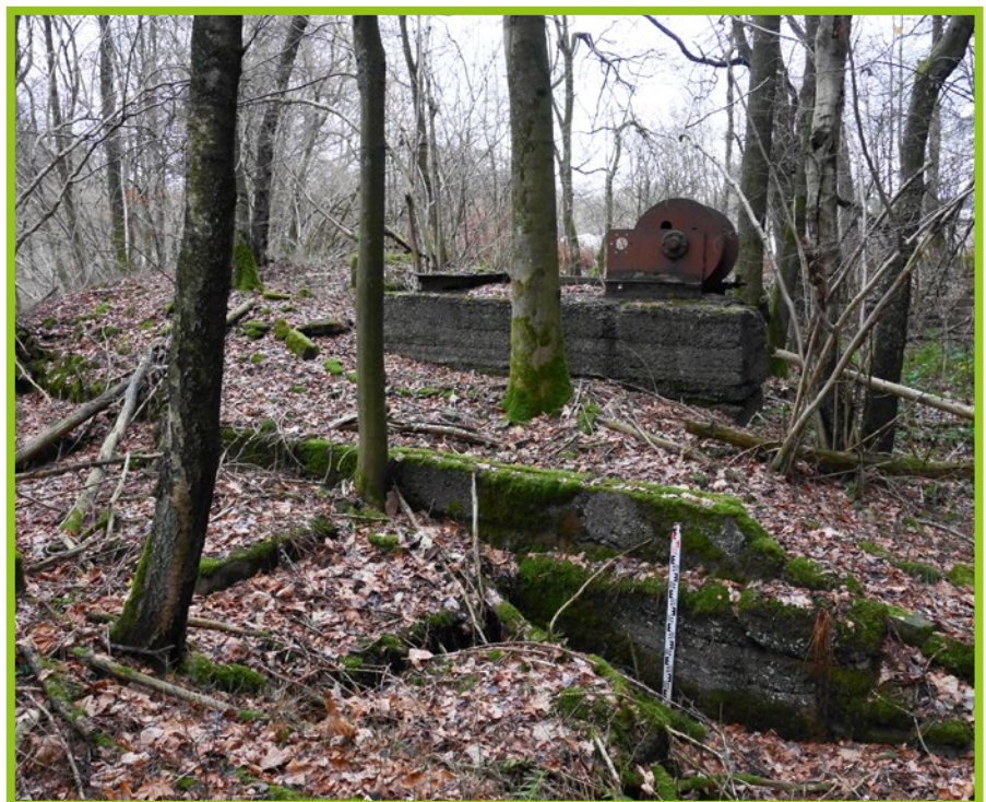
Abb. 3: Doppelseiltrommel und Getriebe der ehemaligen Bremsbahn im Bruch Kotthausen-West. Davor Fundamente eines Gebäudes (2018) (Foto: Jörn Kling).
