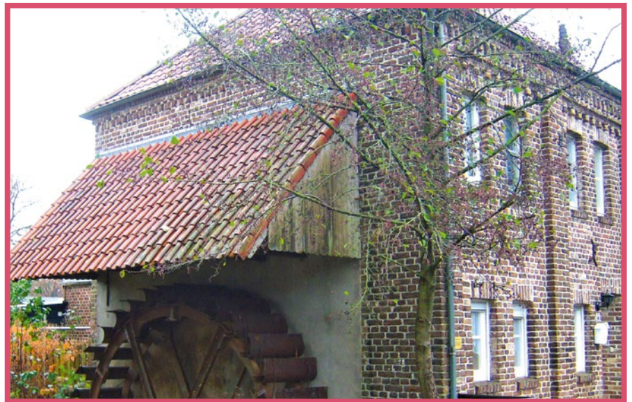
Abb. 8: Johannismühle. Das quadratische, aus Ziegelsteinen errichtete Gebäude der Johannismühle in Xanten ist eine ehemalige Wassermühle. Seitlich am Gebäude ist das eiserne Wasserrad unter einem Schutzdach noch erhalten (Foto: Hans-Michael Altemüller, 2016).
