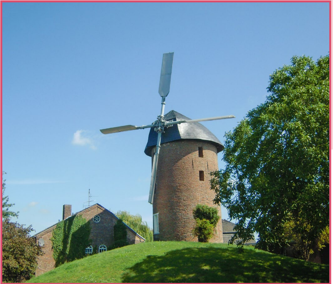
Abb. 1: Düffelsmühle. Die in Kalkar-Niedermörnter erhaltene zylindrische Turmwindmühle wird an ihrer Basis von einem Erdwall umgeben. An der mit Schiefer bedeckten Turmhaube sind Windmühlenflügel aus Aluminium (Bilau-Flügel) angebracht (Foto: Hans-Michael Altemüller, 2019).
